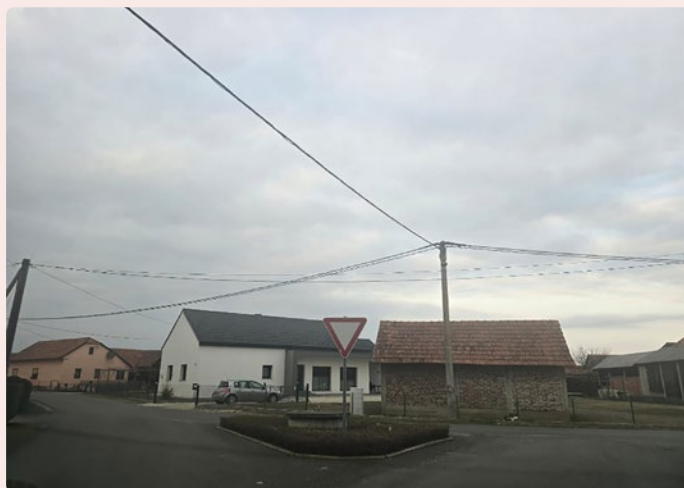
Slika 45: Nepregledno in nevarno Y križišče znotraj strnjene naselja – možnost preureditve križišča ali ureditve križišča s krožnim potekom prometa (s povoznim otokom na sredini) za izboljšanje varnosti udeležencev v prometu
