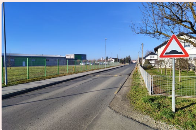
Slika 40: Grbina za umirjanje prometa v Dolinski ulici – potreba po obnovi horizontalne prometne signalizacije
