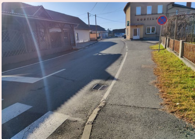
Slika 9: Pločnik na začetku Ravenske ulice, pri semaforiziranem križišču ob OŠ Odranci, ki se na odseku ob gostinskem objektu pogrezne v nivo cestišča in se hkrati zoži, kar zmanjšuje varnost in udobje za pešce.
