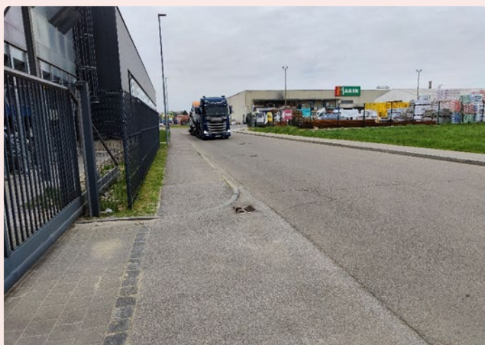
Slika 17: Urejeni obojestranski denivelirani hodnik za pešce v industrijski coni Odranci – izboljšana varnost pešcev
