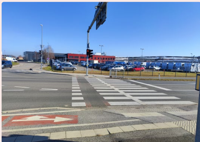
Slika 15: Semaforizirano križišče v Odrancih pri podjetju Carthago in trgovini Jager – ustrezno urejen prehod za pešce s taktilnimi oznakami za slepe in slabovidne
