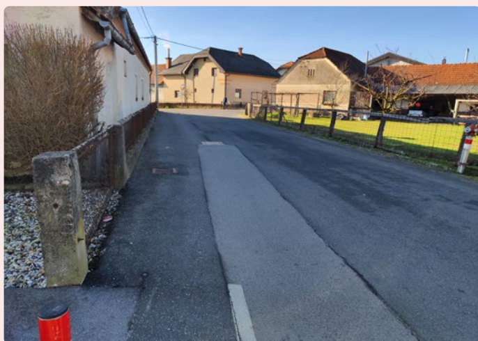
Slika 13: Zaključek ločilne črte med hodnikom za pešce in voziščem – pešec na cestišču brez ustrezne signalizacije
